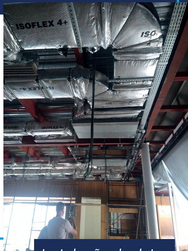
Instalação de dutos
