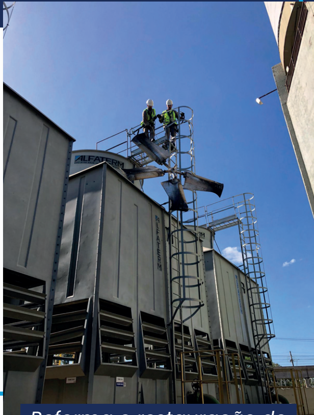
Reforma e restauração de torre de condensação
