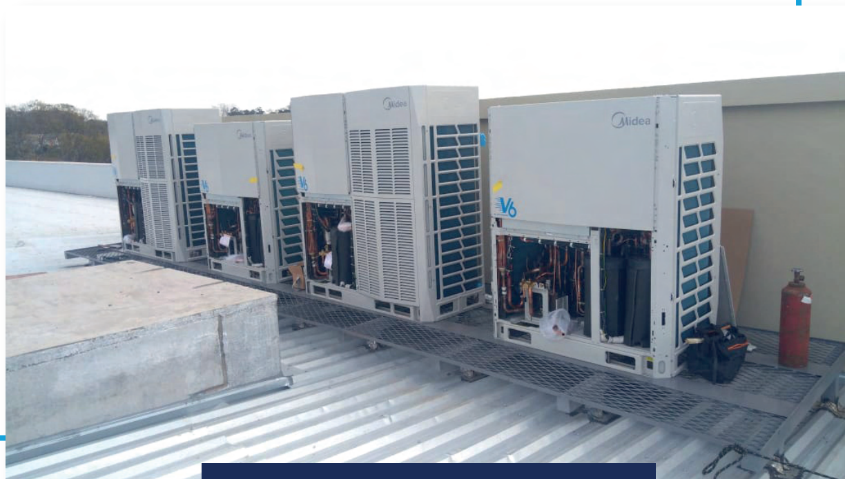
Infraestrutura e instalação de VRF
