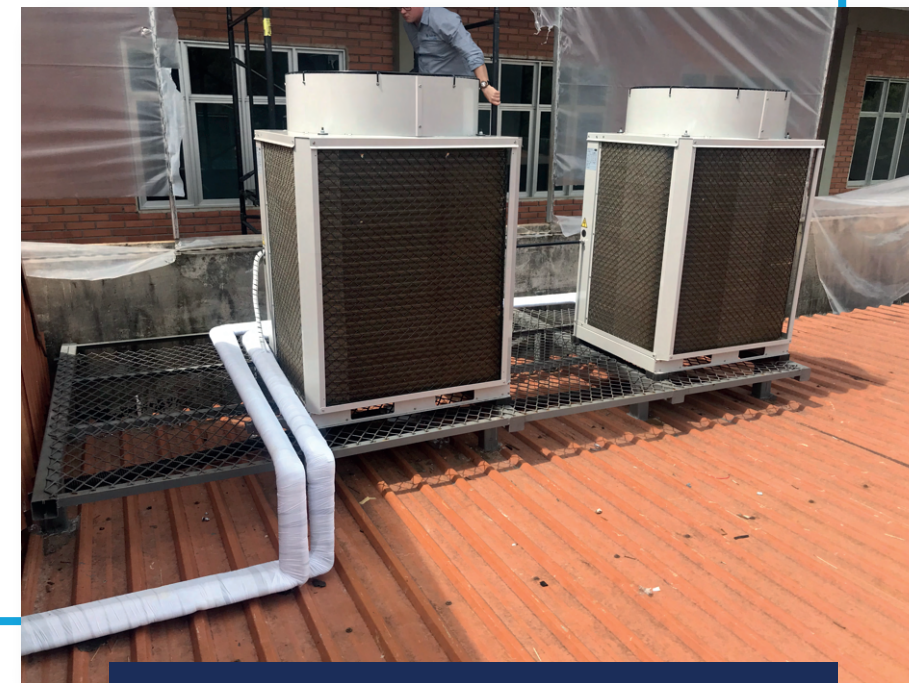
Instalação de ar condicionado central
