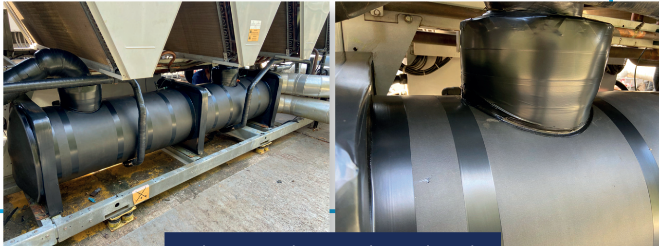
Isolamento de trocadores de calor
